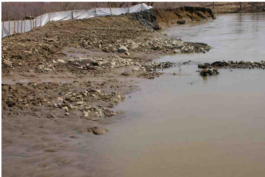
Dolinsk地区、Pugachevka川 2006年3月12日 土砂流入防止フェンスが設置されていても護岸対策は講じておらず、土が河川に流れ込む。
