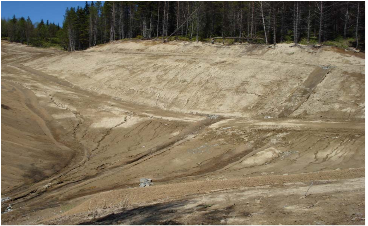
Рис. 3. Начинаяющаяся эрозия в верхней части распадка к северу от п. Фирсово (ПК 483,4). Все склоны изрезаны многочисленными эрозионными бороздами. Русла временных водотоков выложены геоджутом, однако этих мероприятий недостаточно. Биологическая рекультивация (плодородный слой почвы и трава) отсутствует.
