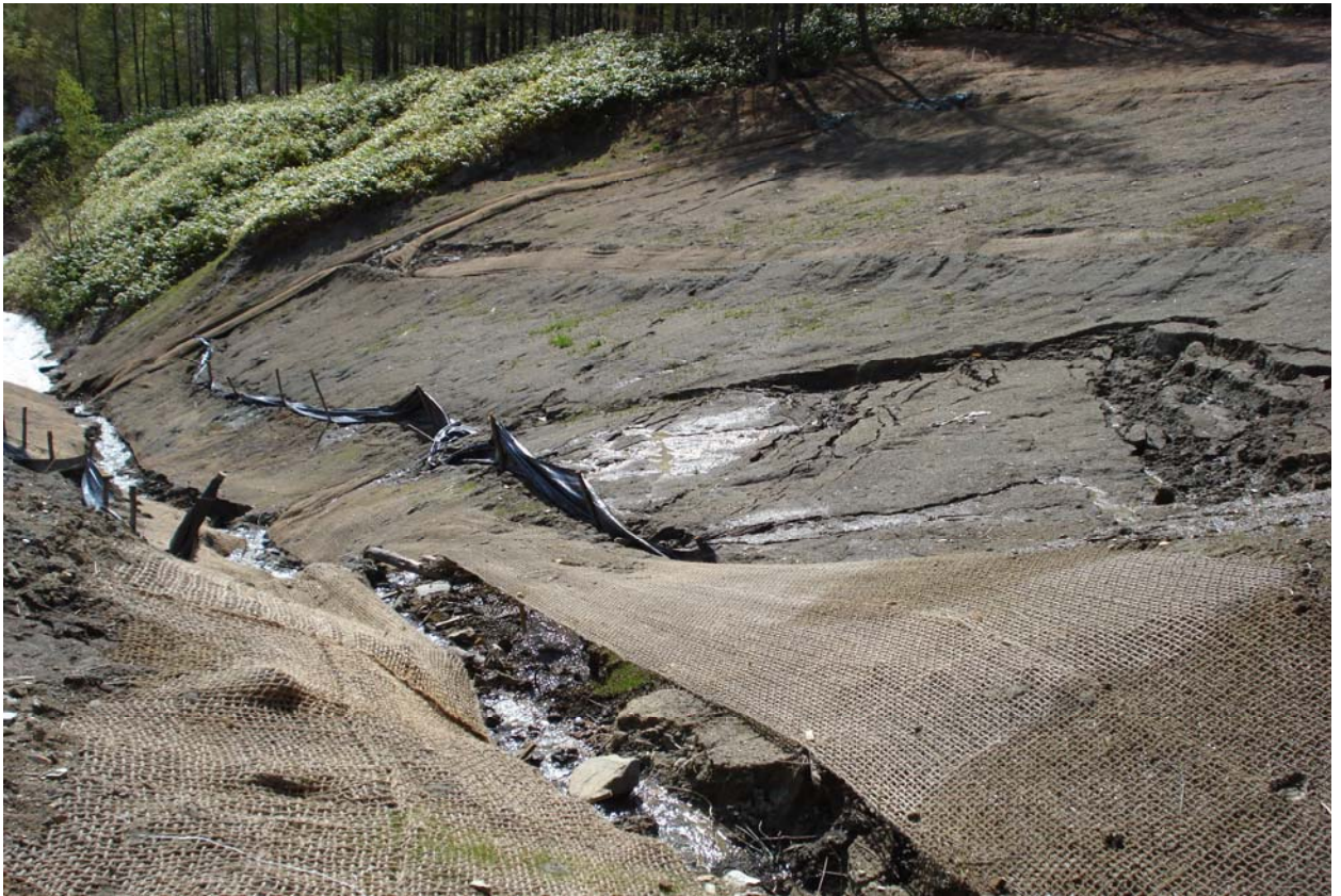
Рис. 11. Оползень на следующем на юг правом притоке р. Красная (ПК 461,7). В данном случае ясно видно, что при наличии выхода грунтовых вод и отсутствии дренажа такие меры как геоджгут, уложенный по берегам ручья, и противоиловые экраны не решают проблему предотвращения оползней. Трава здесь очень скудна и не держит склон.
