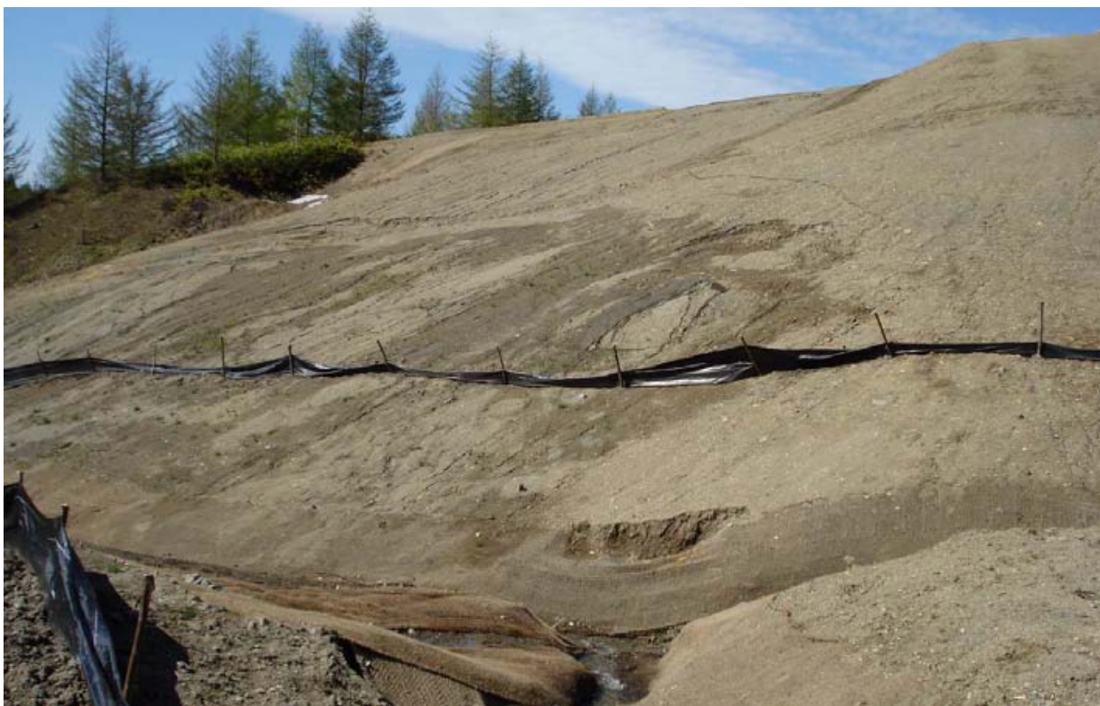
Рис. 10. Зарождение оползня на правом борту правого притока р. Красная ПК (461) Склон начинает сползать вниз из-за обширного выхода грунтовых вод и отсутствия мер по стабилизации грунта. Размеры данного начинающегося оползня приблизительно 20×30 м. На обоих склонах ручья отсутствует биологическая рекультивация.
