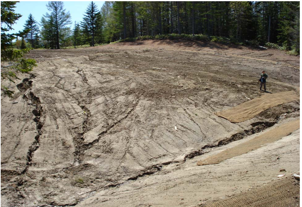
Рис. 4. Крупная эрозионная рытвина к югу от р. Приморская (ПК 482,9) длиной около 25 м и многочисленные эрозионные борозды. Русло ручья не укреплено геоджутом, как это сделано на других подобных участках. Биологическая рекультивация отсутствует.
